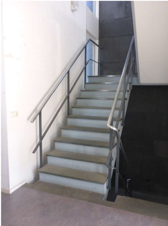
Afb. 22. De hoofdtrap van begane grond naar verdieping
