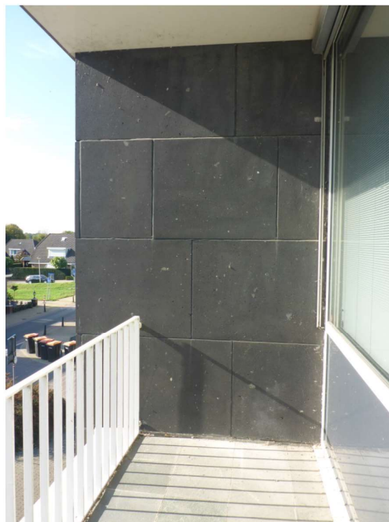
Afb. 21. De aansluiting van loggia tegen de linker zijgevel
