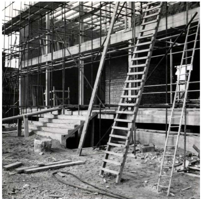
Afb. 7. Het gemeentehuis aan de voorzijde tijdens de bouw [Collectie Historisch Genootschap Heerjansdam]
