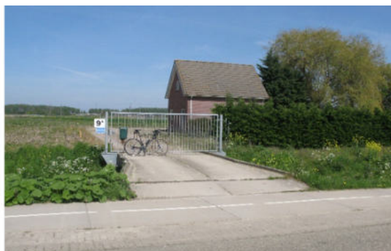
Bestaande inrit naar schuur van SBB.
