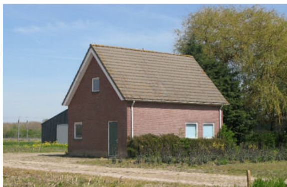
De bestaande schuur.
