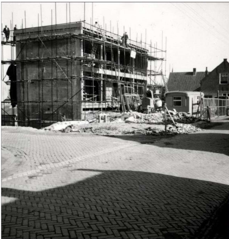
Figuur 11. Gemeentehuis in aanbouw, 1958. Hier is het oude raadhuis al gesloopt.
