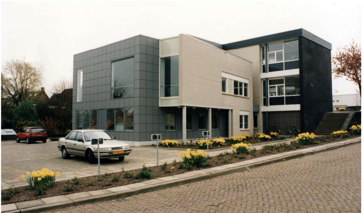
Figuur 17. Achterkant aanbouw uit de jaren negentig.
