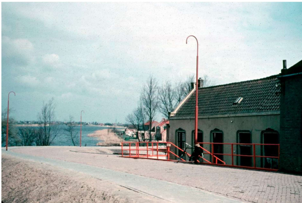
Figuur 5. Ophoging dijk en aanleg verharde straat, 1956-1957.
