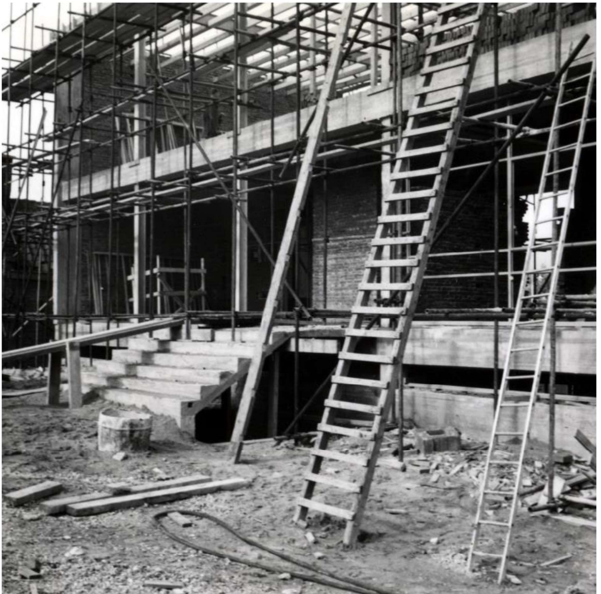
Figuur 12. Gemeentehuis in aanbouw, 1958.
