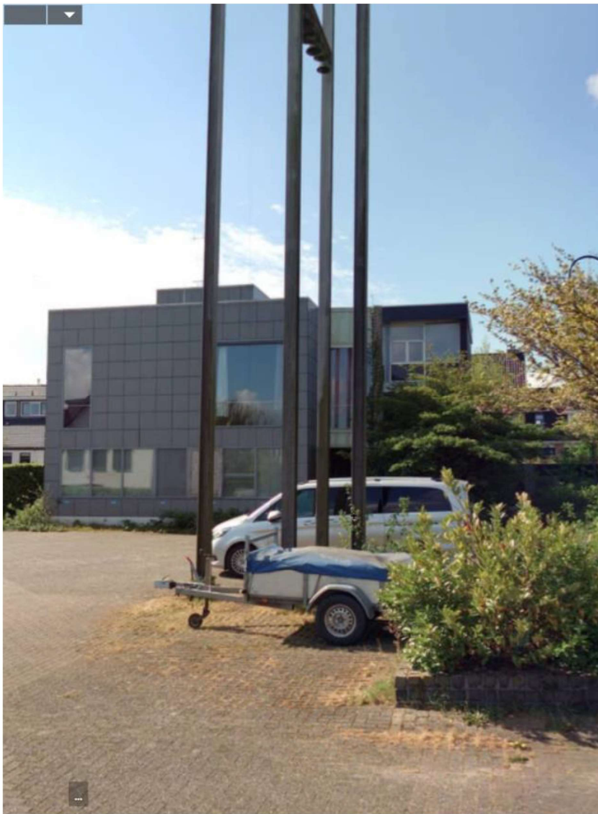
Figuur 18. Achterzijde, situatie 2022.
