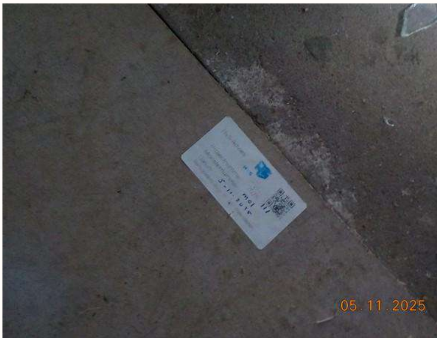
Foto 24: Bron B12, asbestvrij kruipluik
