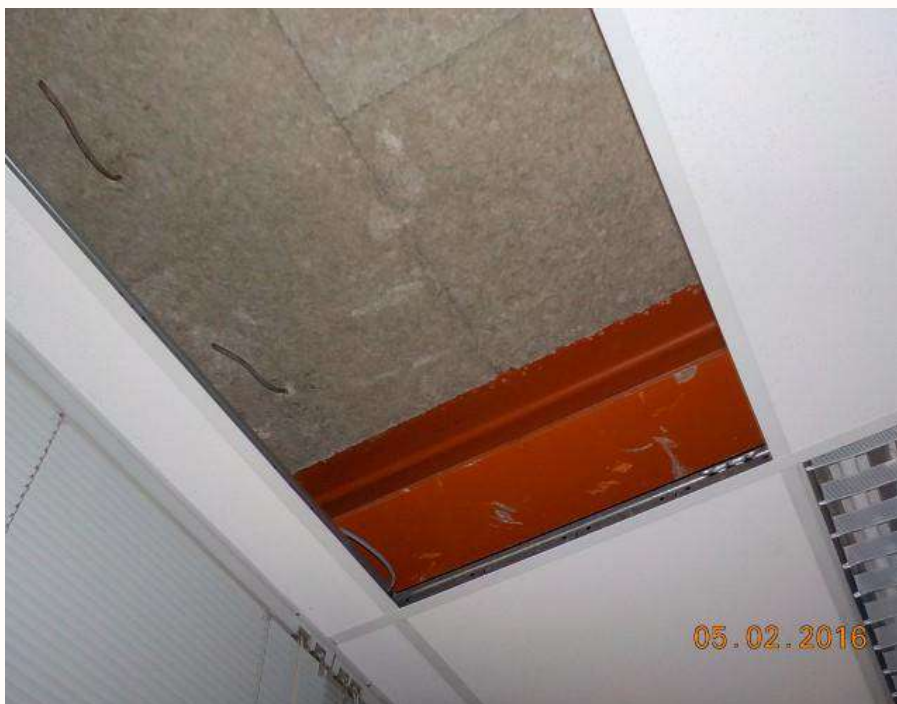
Foto 17: Bron B08, Asbestvrije houtwol cement beplating
