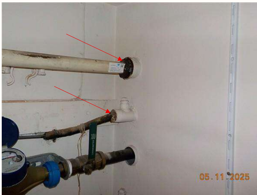
Foto 11: Bron B04, asbesthoudende zwarte kit, doorvoer
