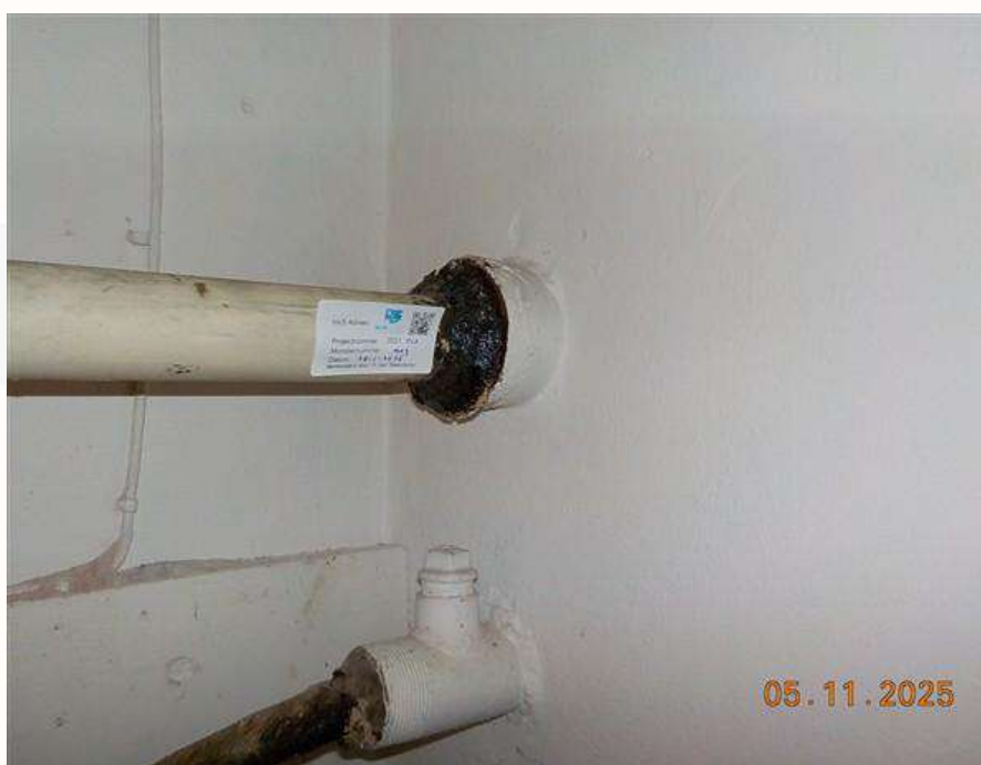
Foto 12: Bron B04, asbesthoudende zwarte kit, doorvoer
