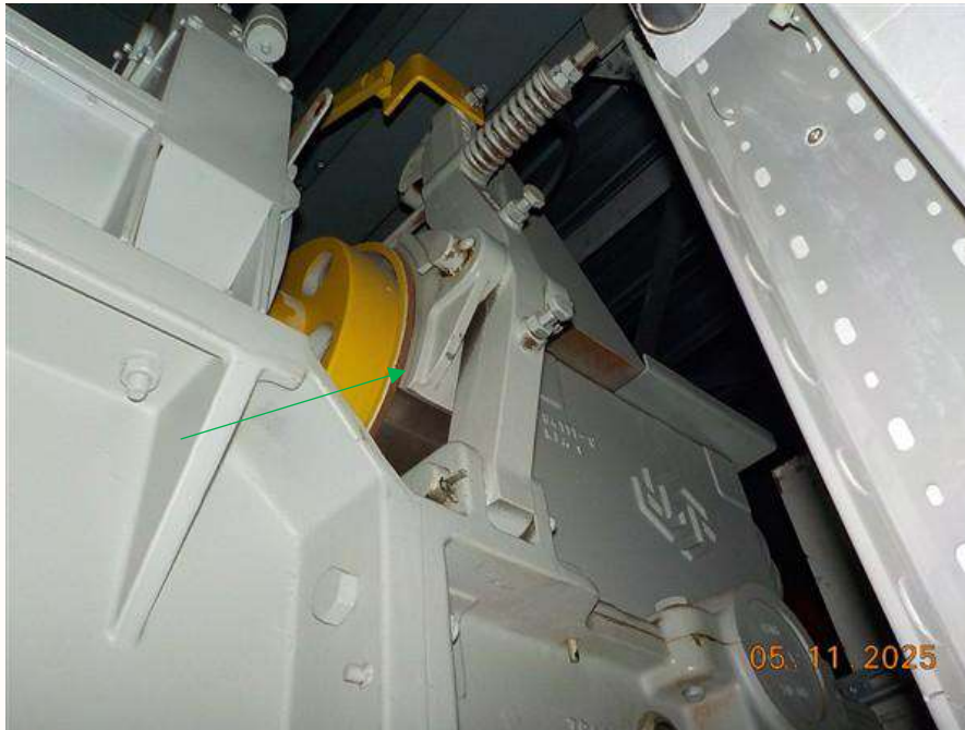
Foto 19: Bron B09, asbestvrije remschoenen liftinstallatie
