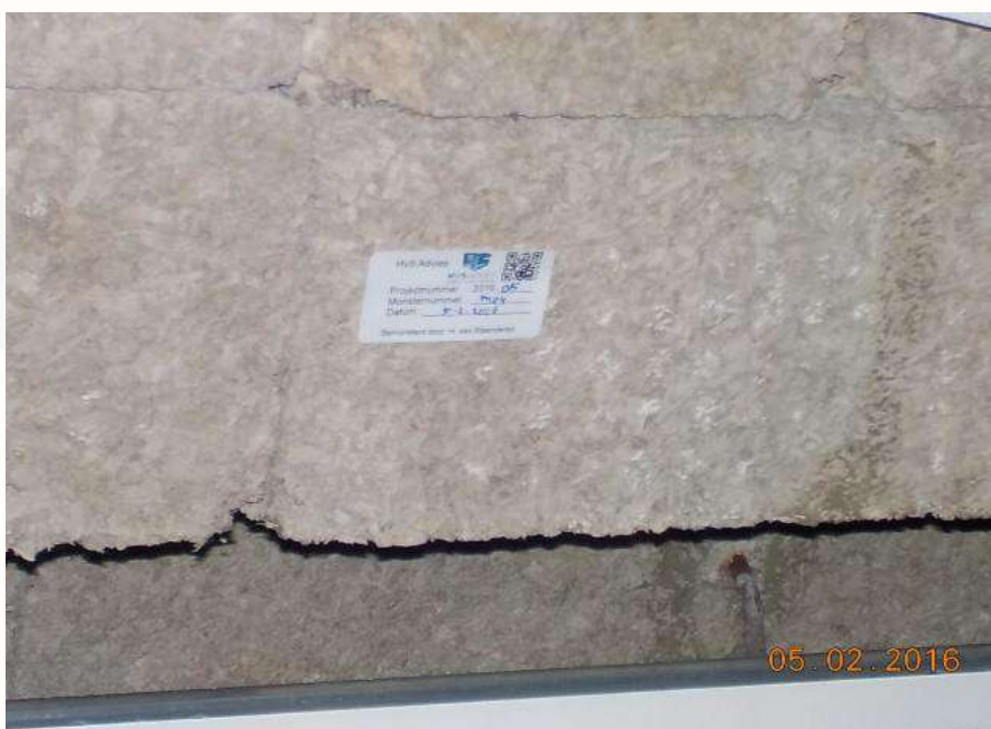
Foto 18: Bron B08, Asbestvrije houtwol cement beplating
