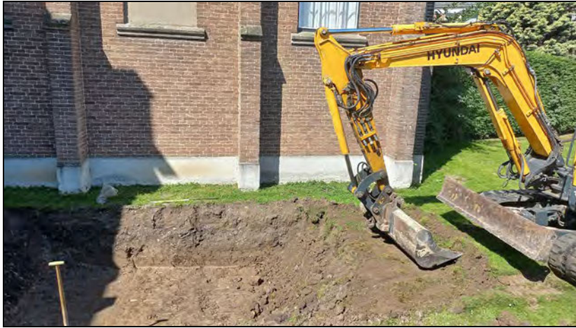
Afbeelding 11. De aanleg van de proefsleuf. Op de achtergrond is de oostelijke muur van de aanbouw uit 1874 zichtbaar. De foto is genomen vanuit oostelijke richting.
