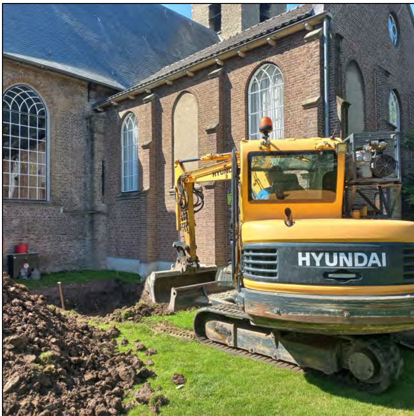
Afbeelding 10. De aanleg van de proefsleuf. De foto is genomen vanuit noordoostelijke richting.
