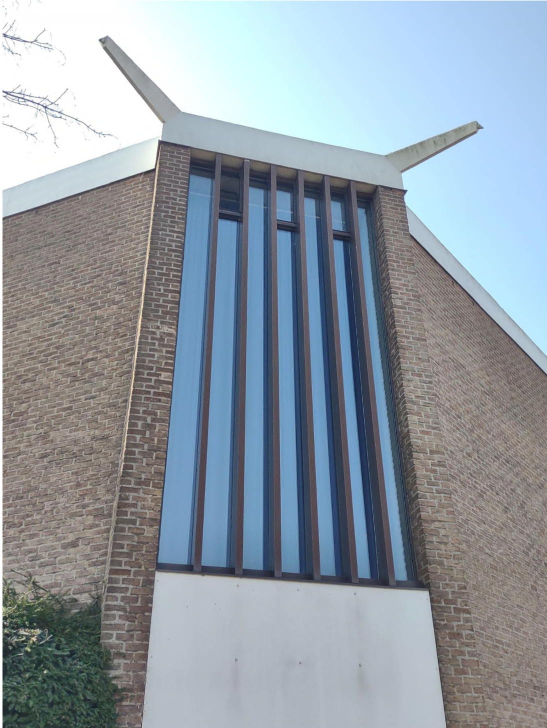
Afbeelding 7: Gevel kerk met bovenin open stootvoegen
