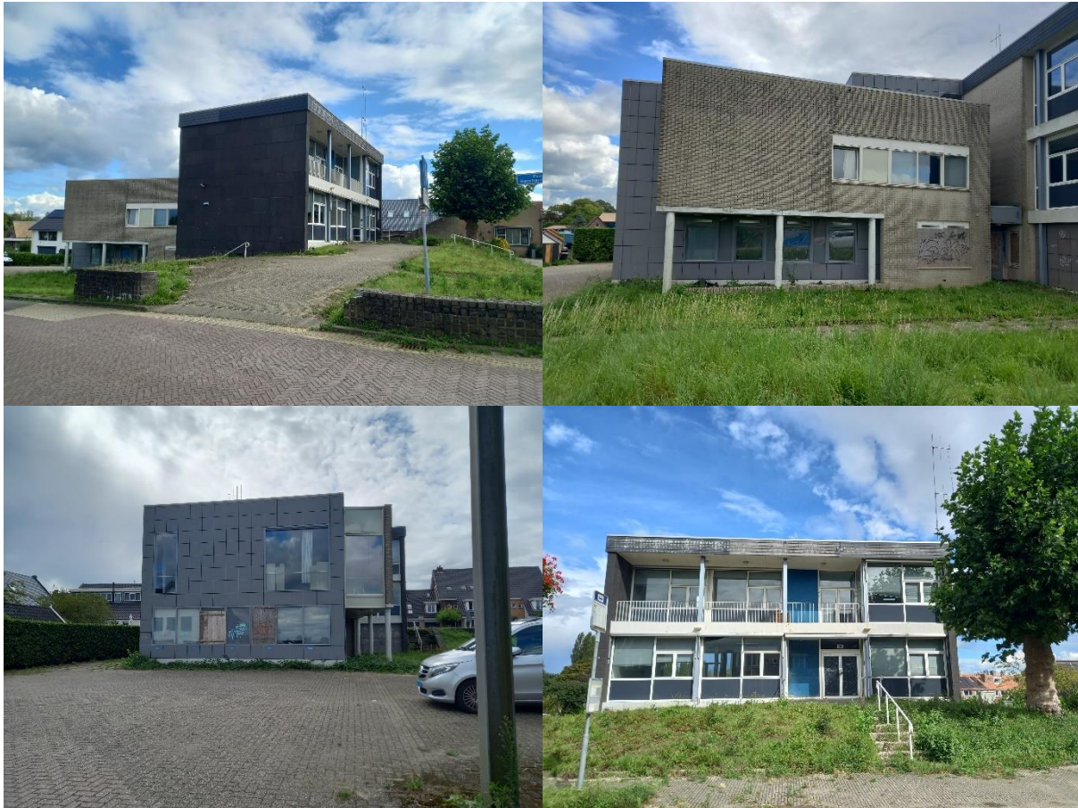
Figuur 2. Impressie onderzoeksgebied. Linksboven voor en zijkant van het gebouw en kale perken. Rechtsboven aanzicht westelijke zijgevel. Linksonder aanzicht parkeerplaats en noordgevel gebouw. Rechtsonder voorkant van het gebouw met overgebleven plataan.
