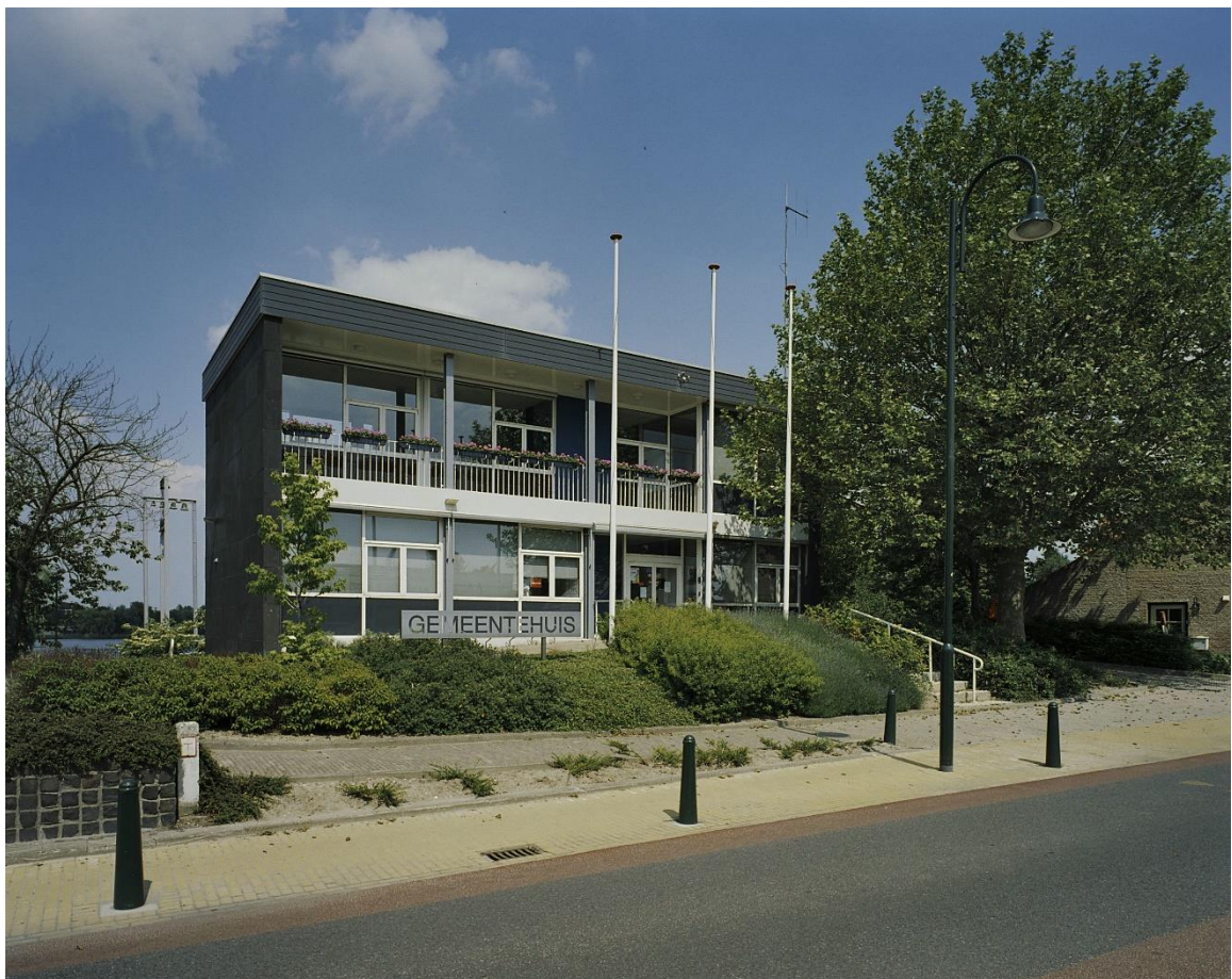
Figuur 12 Gemeentehuis van voren. Het voorplein sterk verhoogd en voorzien van een glooiing, waardoor de herkenbaarheid van het opgetilde volume verloren is gegaan. Linksachter staat de klokkentoren. Bron: RCE
