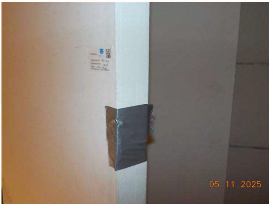
Foto 20: Bron B10, asbestvrije deur, cv ruimte kelder
