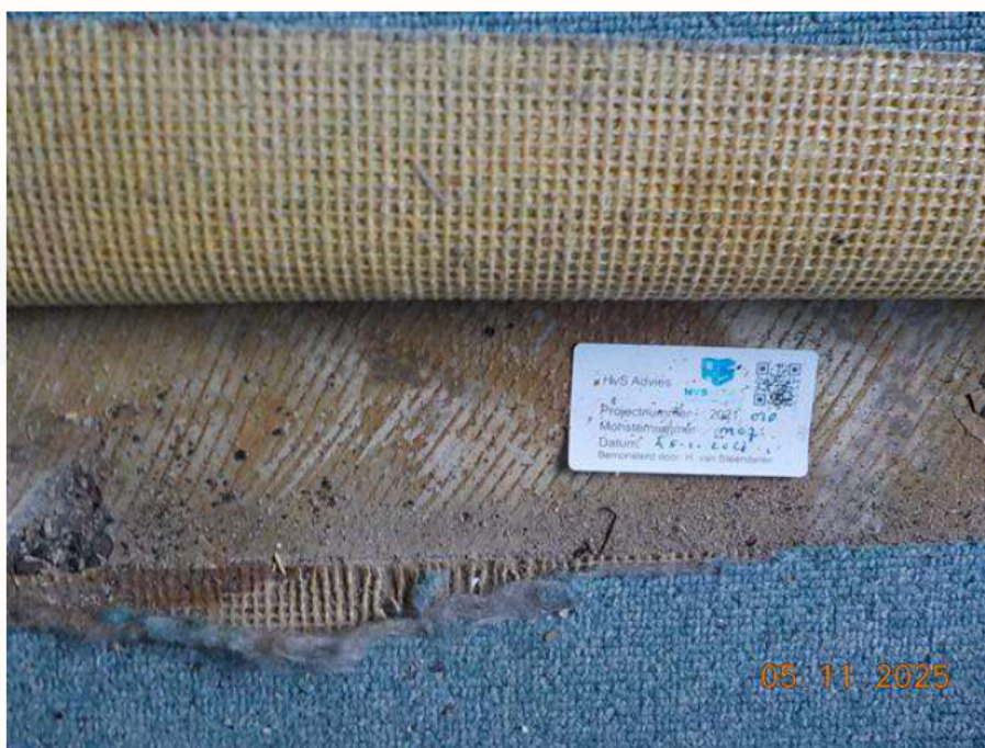
Foto 10: Bron B03, Asbesthoudende zwarte lijm, vloeren, oude deel v.m. Gemeentehuis M07
