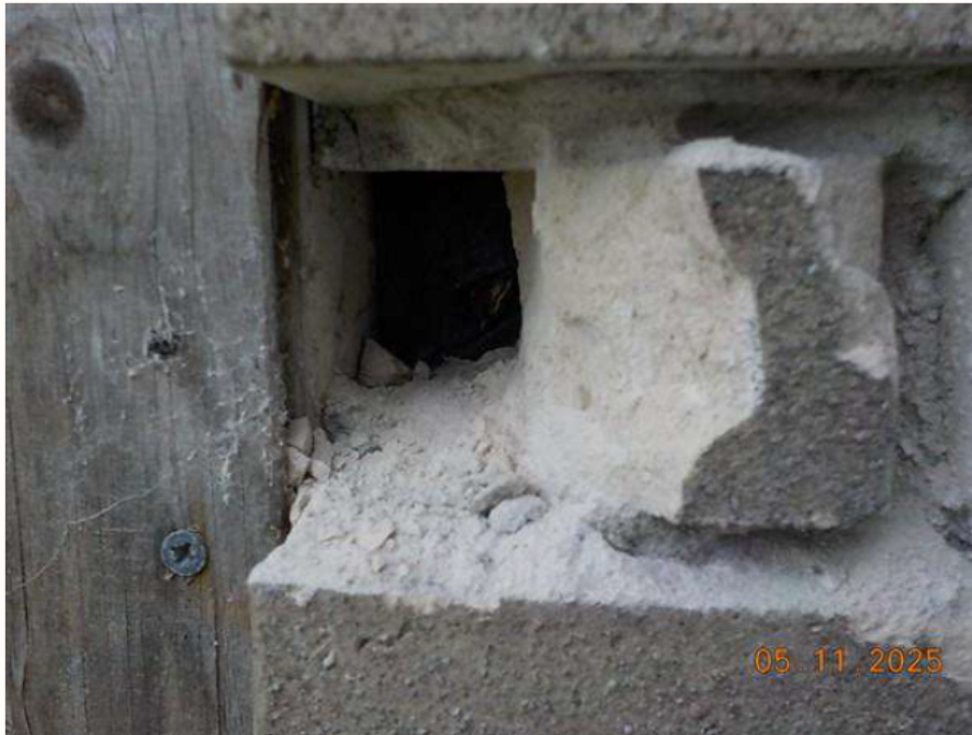
Foto 25: Spouwmuren zonder verdachte stroken
