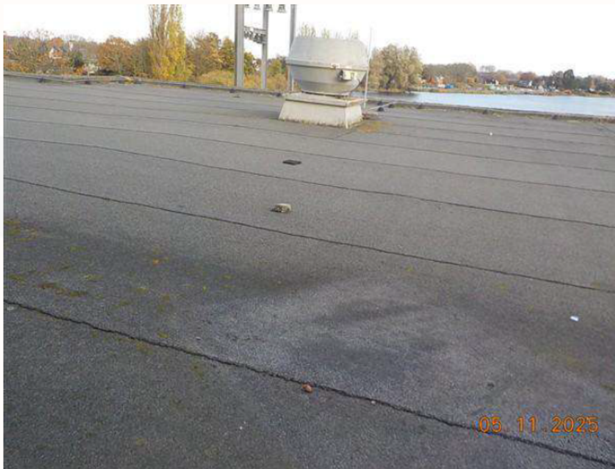
Foto 26: Niet verdachte bitumen dakbedekking
